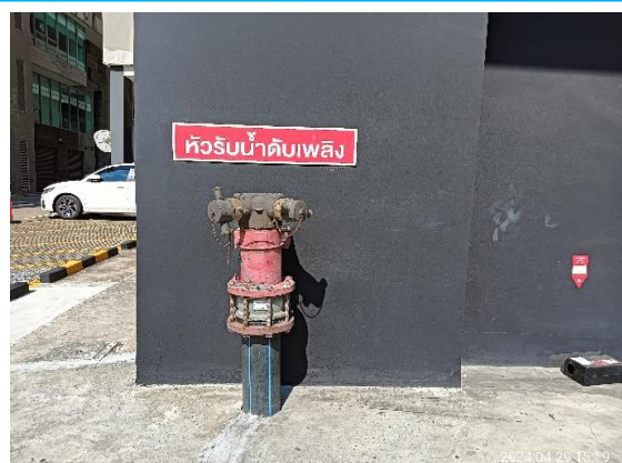
รูปที่ 3-42 หัวรับน้ำดับเพลิงภายนอกอาคาร
