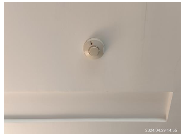
รูปที่ 2.9-2 Smoke Detector
